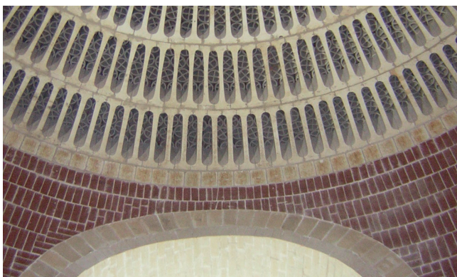
Freitragender, keramischer Kuppelrost
