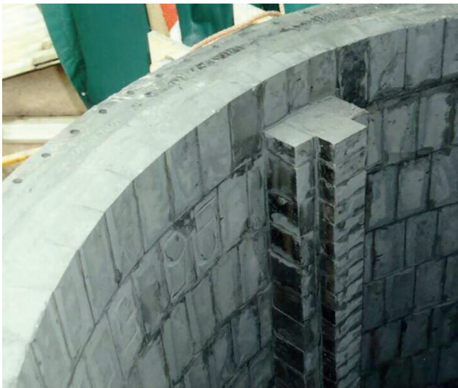
Aufbau der Ausmauerung
