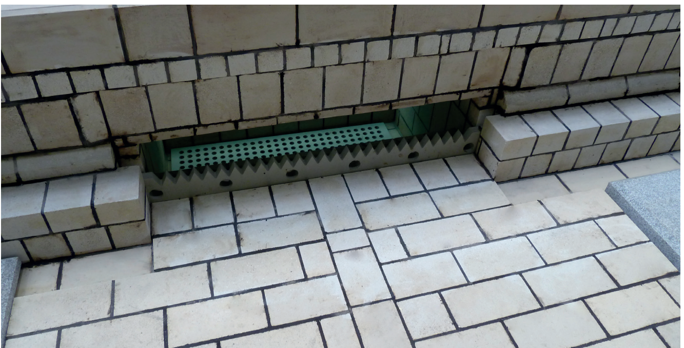
Ausmauerung mit CHEMOKITT FU 1310
