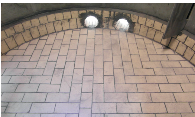
Ausmauerung eines Behälterbodens mit Asplit CN
